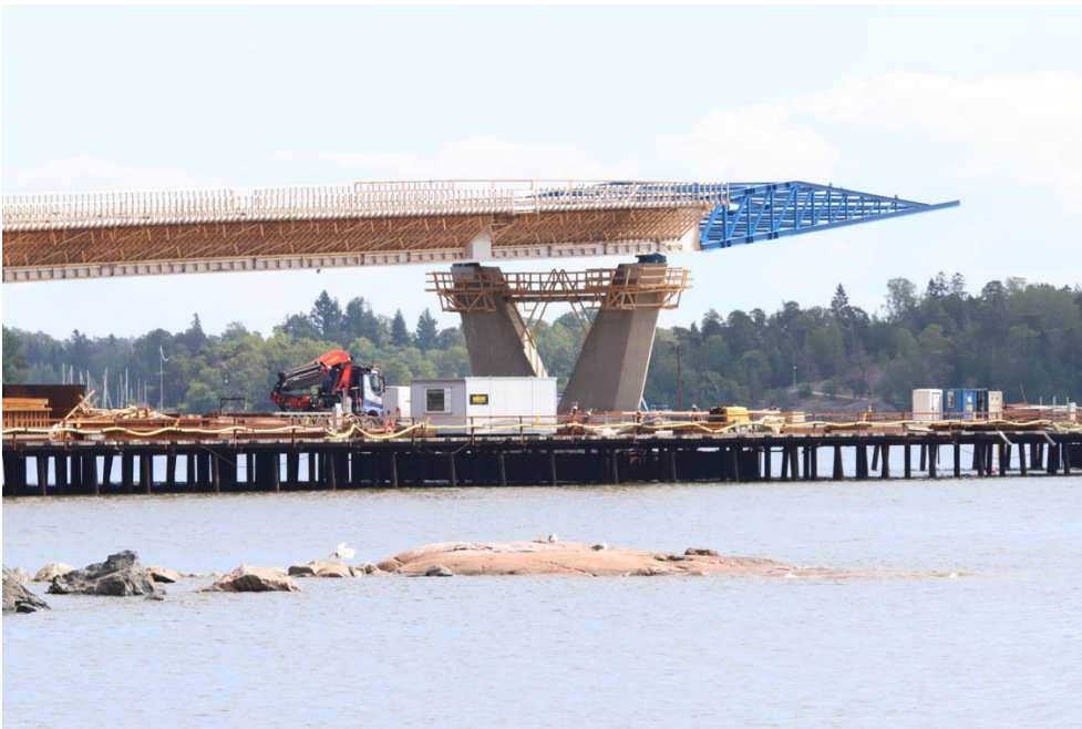
Kuva I-1. Sillan kansirakenne edistyy Korkeasaaren suunnasta.
